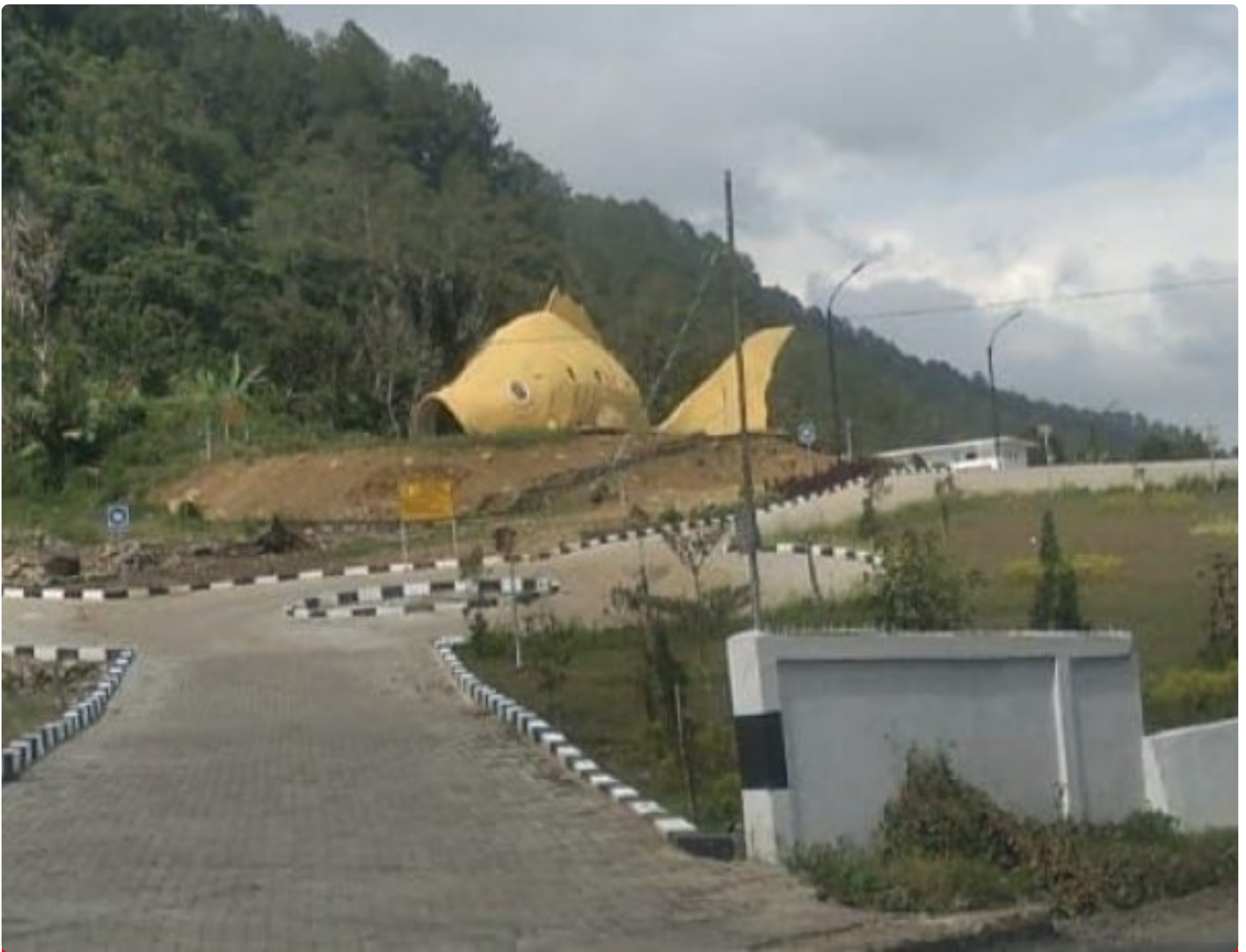
Proyek Pembangunan Ikan Mas Sipolha
